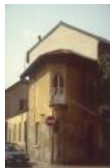
Casa Via Matteotti angolo Via Guarnazzola
