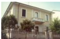
Casa Repossini, Della Vedova
